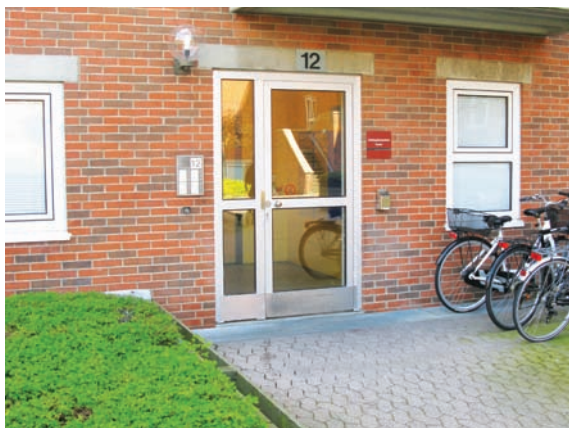
Prøveopgang med akustikstyret belysning i Hegnsgården.
