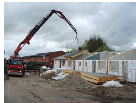
Ældreboligerne under opførelse
